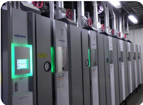
第一工場ボイラー更新
